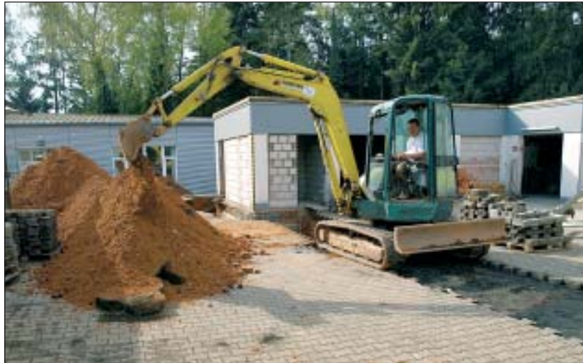
Baubeginn: Wo jetzt der Bagger mit den ersten Arbeiten begonnen hat, entsteht bis Ende 2010 ein zukunftsweisendes Dienstleistungszentrum. (Foto: GfMB)
